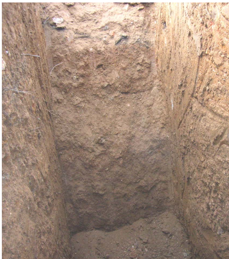
Fig. 13 – Trincea geognostica eseguita presso la S.S. 589.
