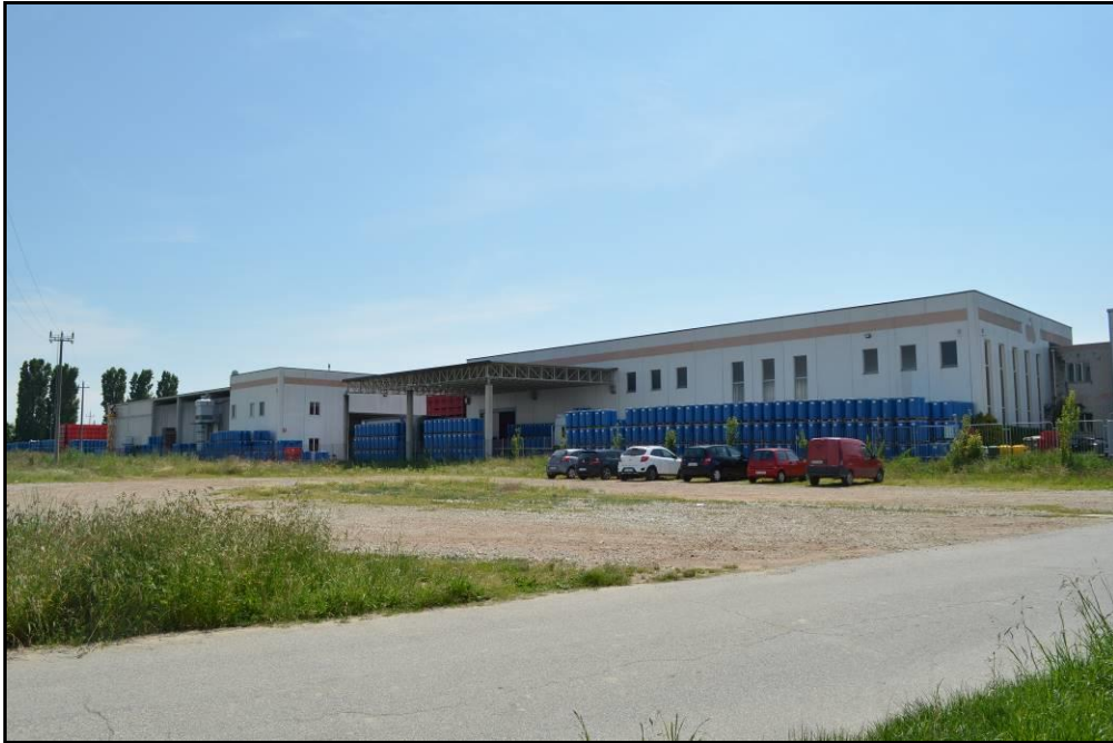
Vista su lotto non ancora edificato
