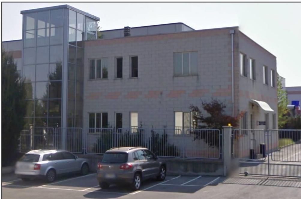
Vista del blocco uffici con accesso dalla strada locale .
