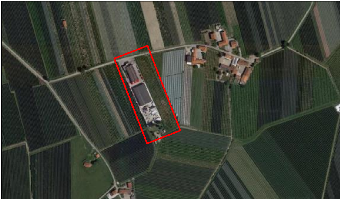
Fig.7: foto aerea dell'area oggetto di intervento e del suo contesto.
