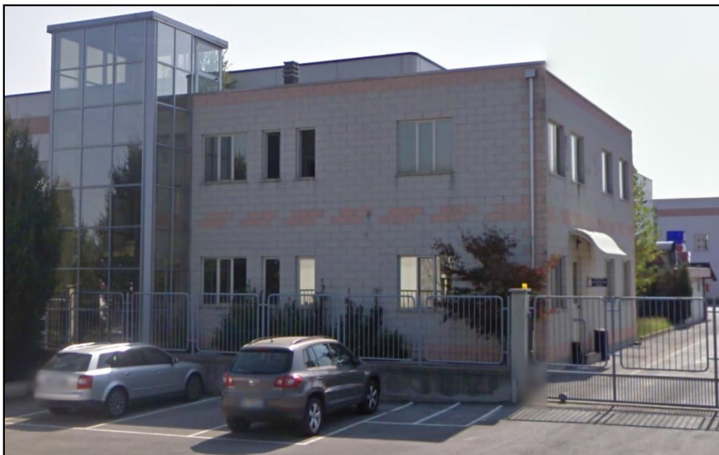
Fig.9: vista del blocco uffici con accesso dalla strada locale .
