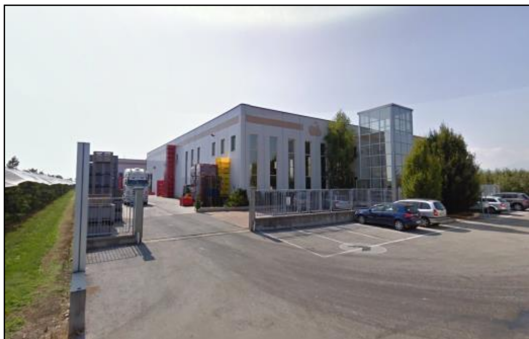
Fig.10: principale accesso all'area produttiva con vista su parcheggi.
